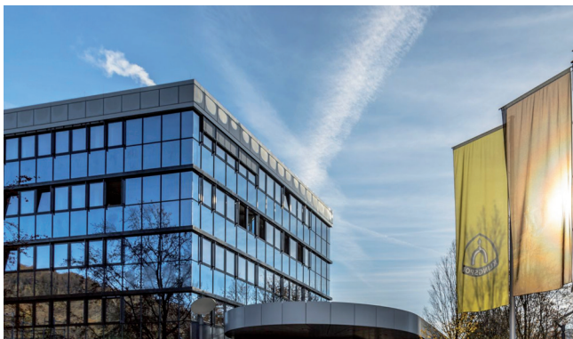
Fassadensanierung Verwaltungsgebäude Klingspor AG (Haiger)
